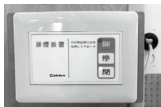
▲写真4：排煙装置 「建物の規模」「道場がある階数」「窓の有無」「内装の仕様」などの条件次第で、排煙設備の設置が必要になるケースと免除されるケースに分かれます。
